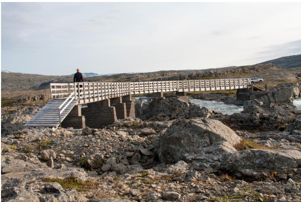
Mynd 2.8 Göngubrú yfir Hvalá ofan Hvalárfoss. Horft til suðurs (EV 2015).
